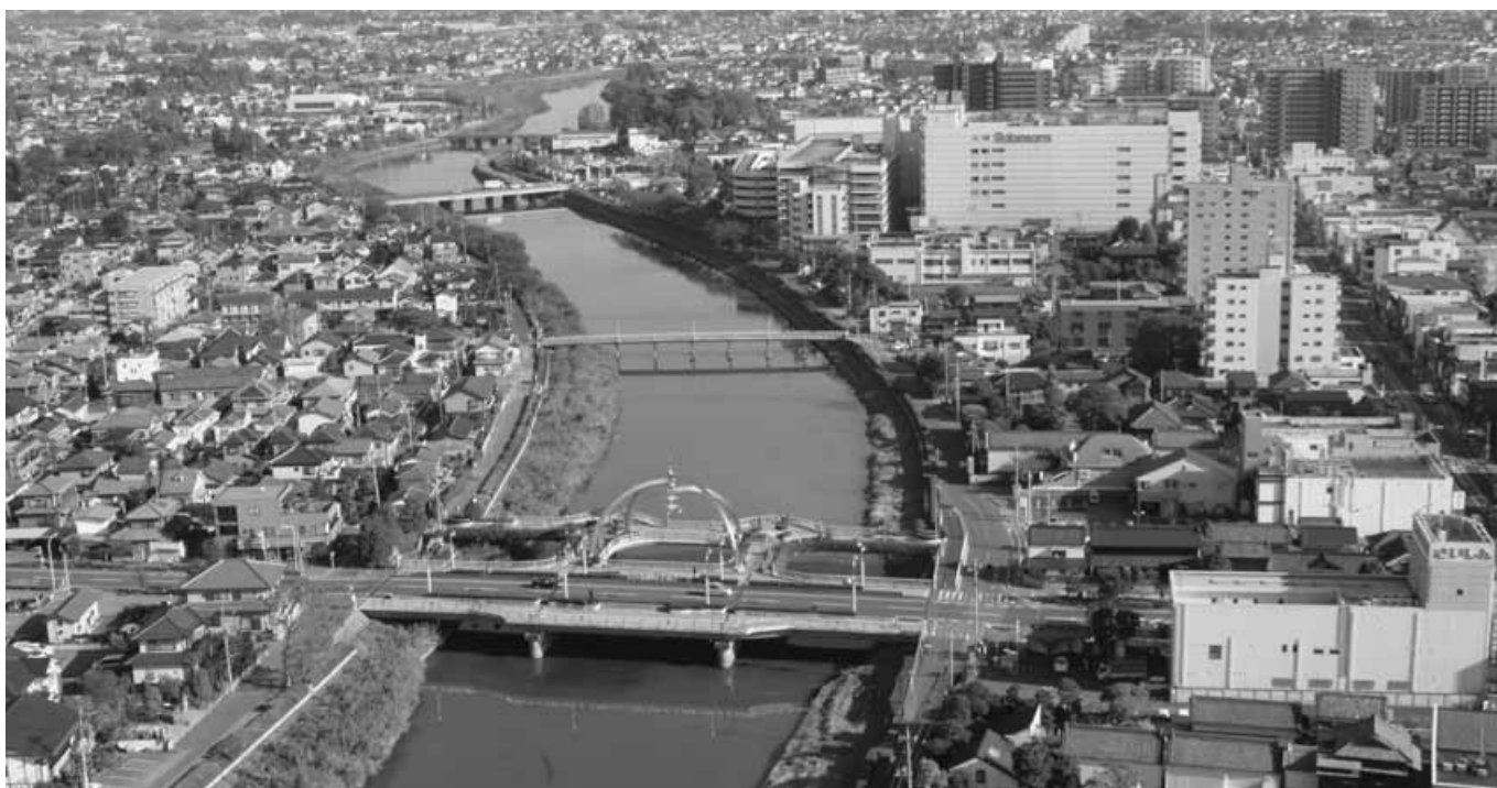
粕壁三丁目高層建物から眺望した古利根川
